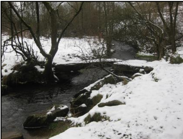
Abb. – Steinbrücke am Kallenbach.
